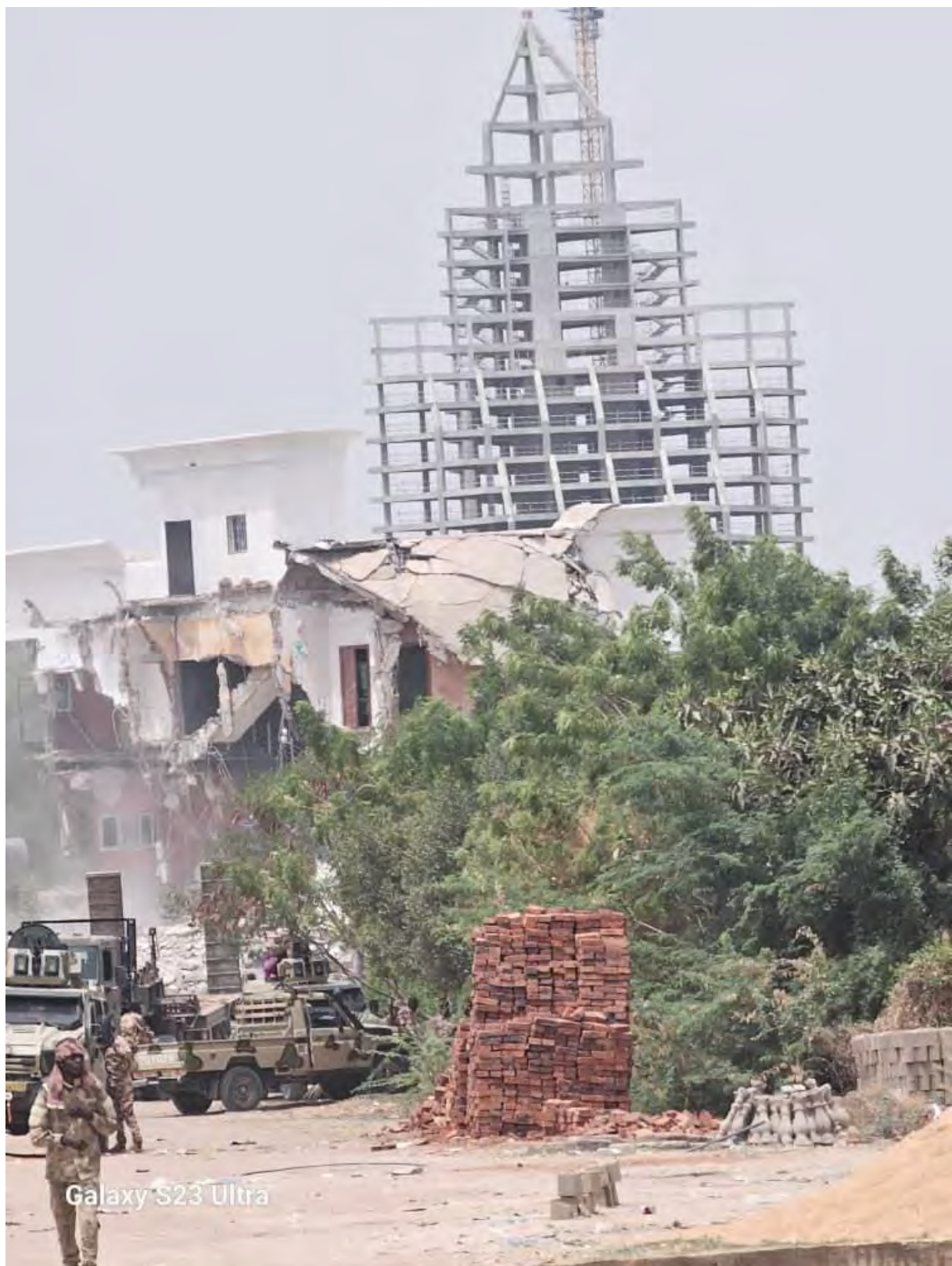
Illustration 2 : Démolition du siège du PSF
